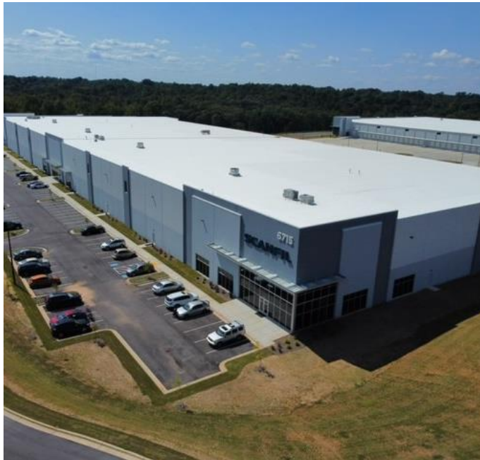
Atlantan tehtaan laajennus Yhdysvalloissa
